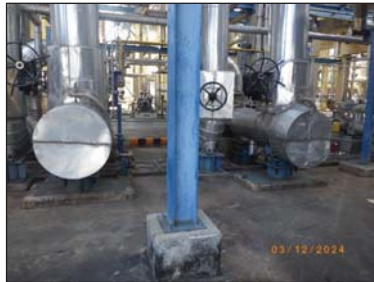
รูปที่ 3.14 Acoustic Insulation (G-624 A/B)
