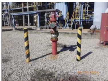
รูปที่ 3.43 Fire Water Monitor
