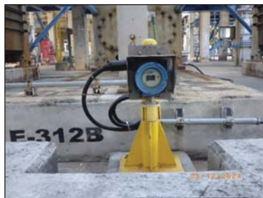
รูปที่ 3.54 Hydrocarbon Gas Detector
