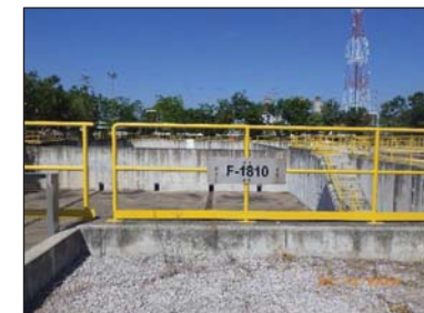
รูปที่ 3.60 บ่อ F-1810 รองรับการรั่วไหลของสารเคมี
