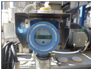
รูปที่ 3.52 Flammable Gas Detector
