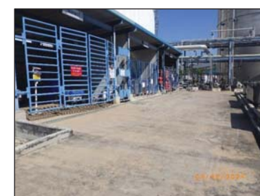
รูปที่ 3.13 พื้นคอนกรีตป้องกันการรั่วซึมของสารอินทรีย์
